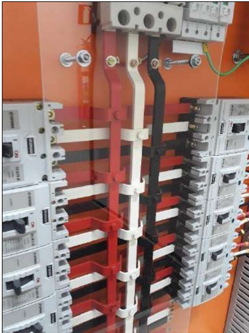
Figura 40. Padrão de barramento dos QDs.
