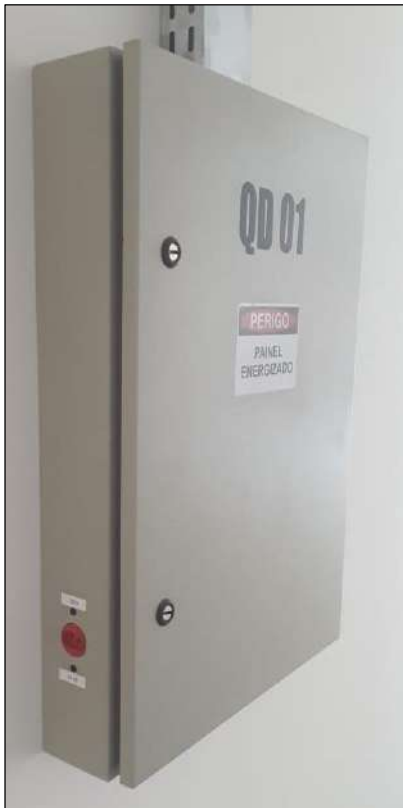
Figura 52. Exemplo de tomada no painel.
