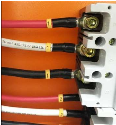
Figura 42. Anilhas e termocontratil.
