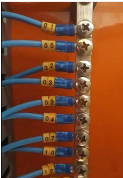
Figura 44. Anilha e terminal – Neutro.
