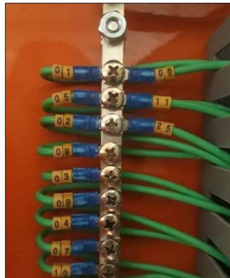
Figura 45. Anilha e terminal – Terra.
