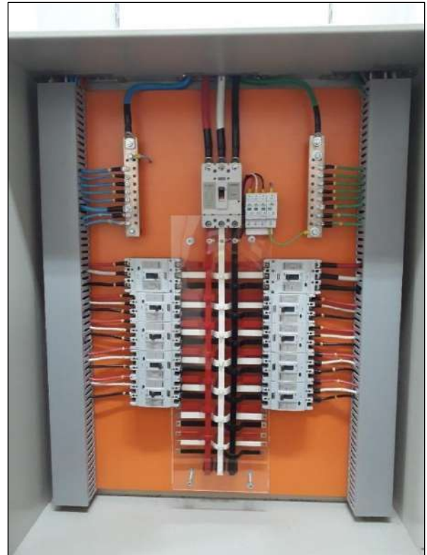
Figura 41. Padrão de montagem.
