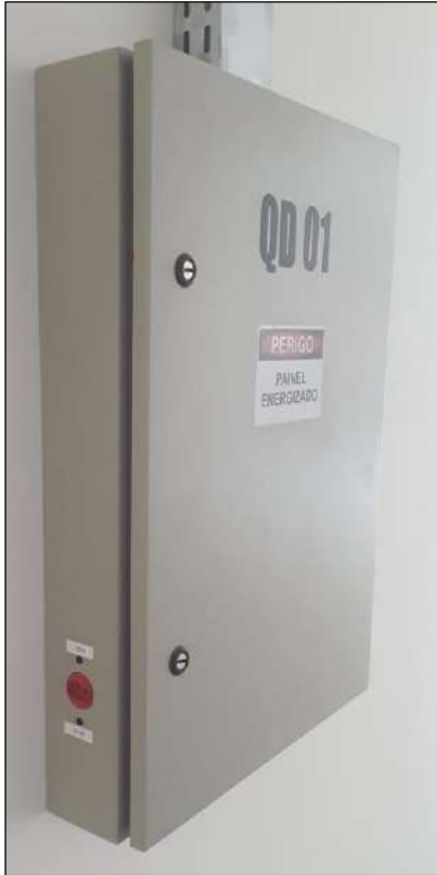
Figura 52. Exemplo de tomada no painel.
