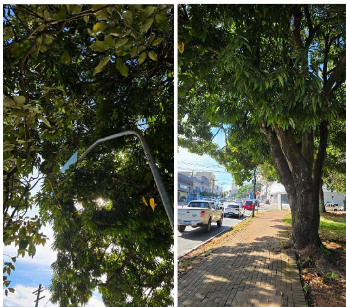
Figura 4: Exemplar de Mangueira que necessita de poda Fonte: Vistoria in loco
