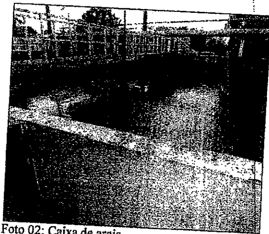
Foto 02: Caixa de areia.
