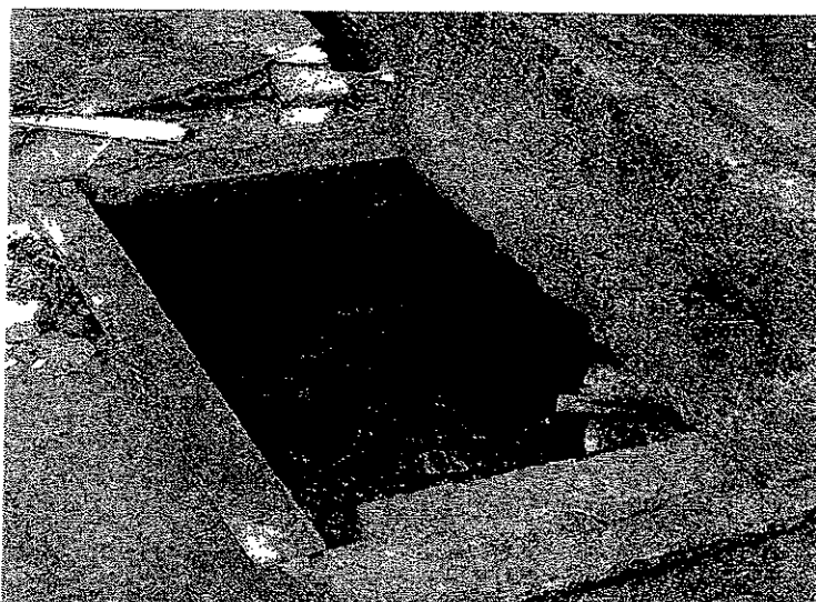
Lançamento de efluente doméstico na rede pluvial
