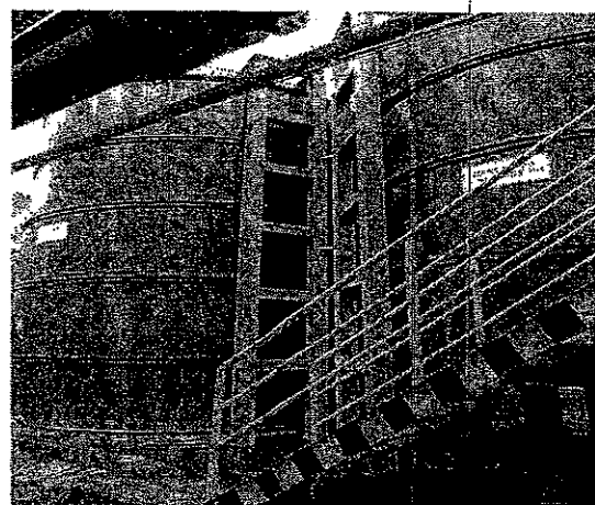
Foto 06: Tanque de correção de pH.
